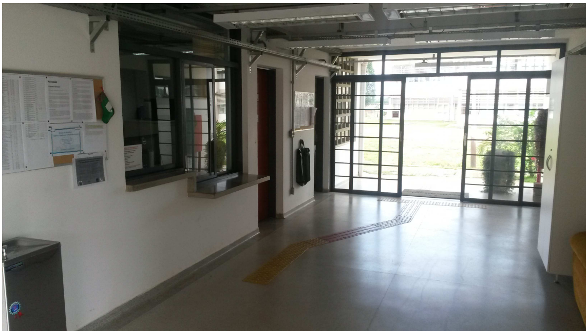
Foto 3. Entrada principal do prédio (Secretarias).
