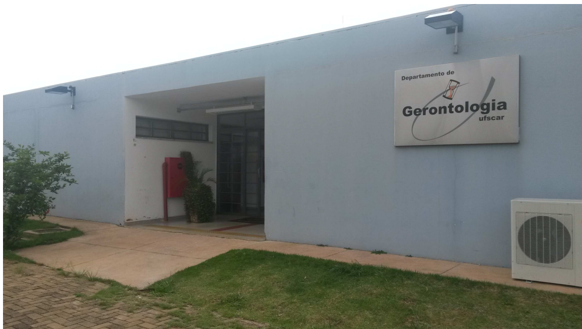
Foto 1. Vista da entrada principal do prédio
