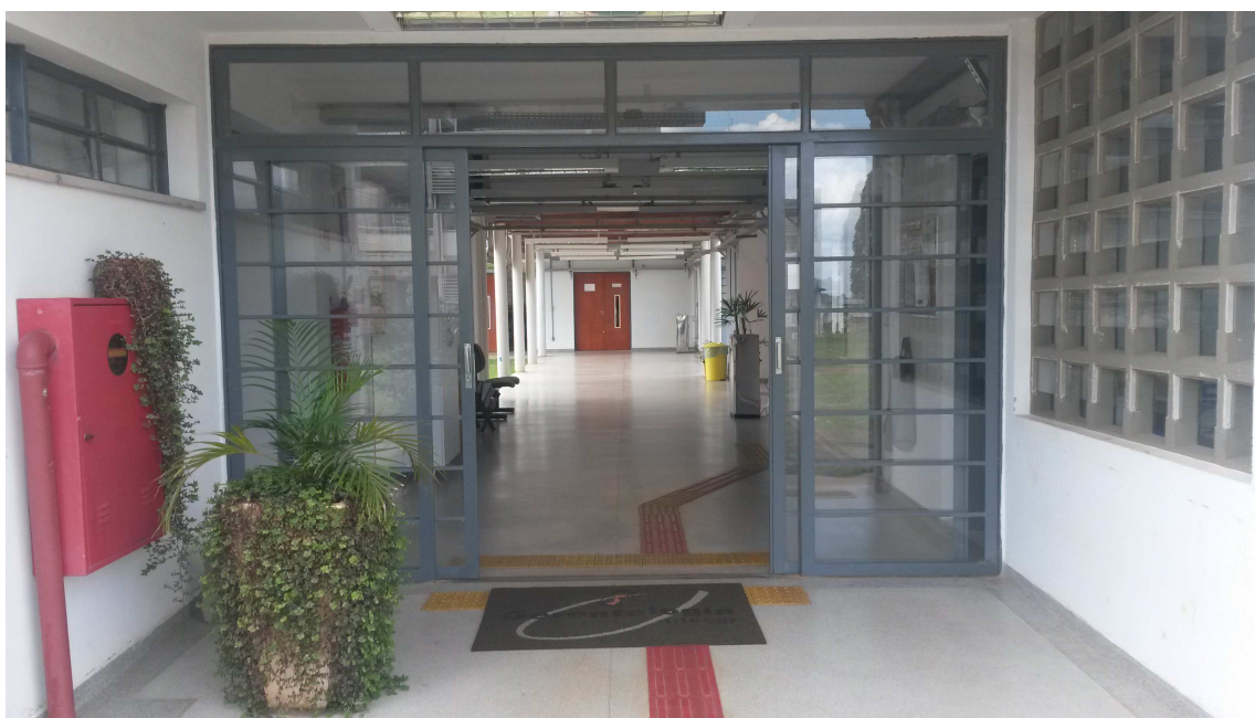
Foto 2. Vista da entrada principal do prédio
